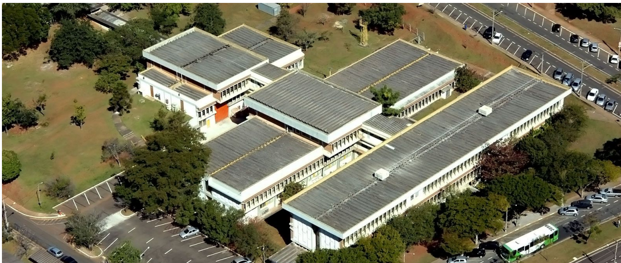
Vista aérea do prédio principal da FEEC.
