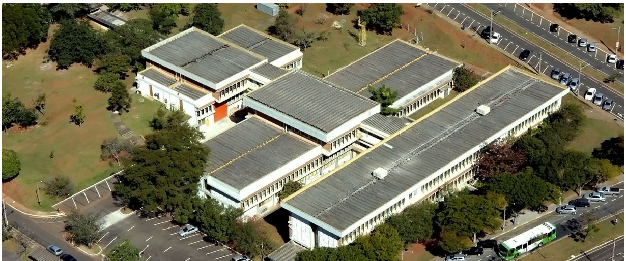
Vista aérea do prédio principal da FEEC.
