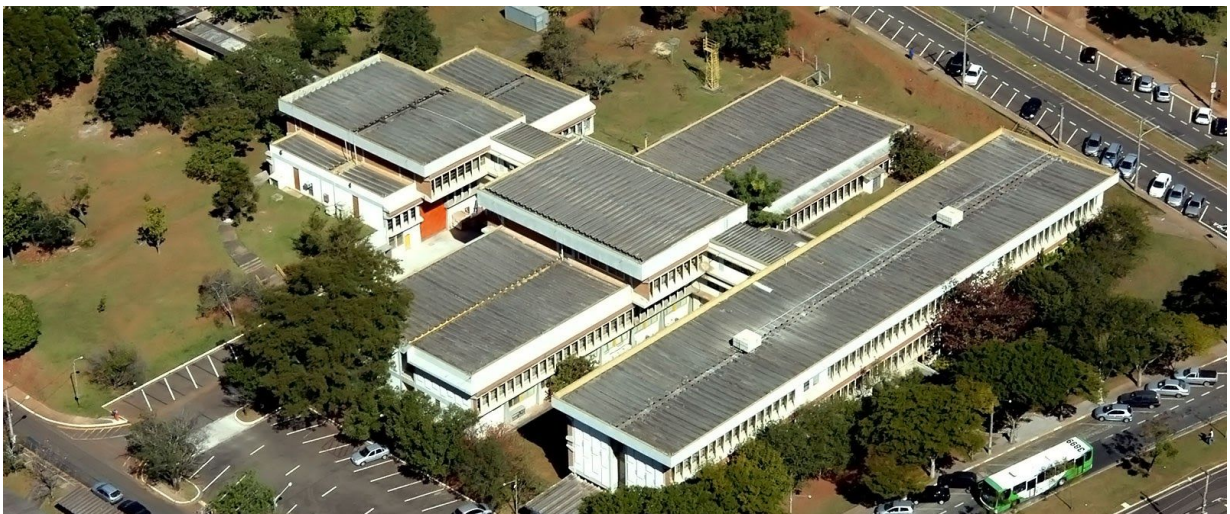
Vista aérea do prédio principal da FEEC.
